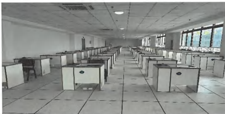
图 25: 市安全生产考试中心智能机房
